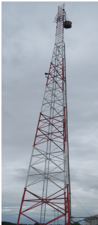
Photo du haut : Un exemple des structures existantes sur la ligne de transmission 924L/927L.
